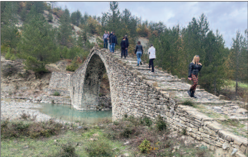
Η επίσκεψη στο γεφύρι Κουσιουμπλή χαιρετισμό προς τους εκπροσώπους της Εταιρείας. Κατα τη διάρκεια της επιστροφής επισκεφθήκαμε το εντυπωσιακό μονότοξο γεφύρι «Κουσιουμπλή».
